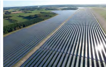
Фотоэлектрические инверторы для солнечной электростанции мощностью 75,4 МВт (Дания)
