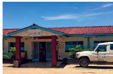
Системы возобновляемой энергии с использованием Eltek Rectifier для 104 больниц в Зимбабве по Программе ООН
