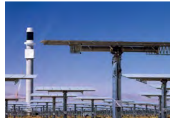
Система слежения за Солнцем для электростанции в США
